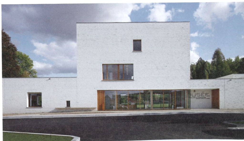
Façade sur la ruelle et le parking.
