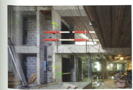
Ci-dessus : vues du chantier, montrant le délicat travail de conservation, démolition, transformation des structures existantes.
